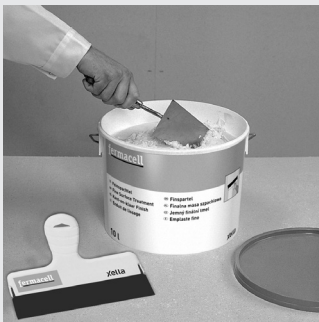
Bild 38: Flächenspachtelung mit fermacell Feinspachtel und mit fermacell Gips-Flächenspachtel
