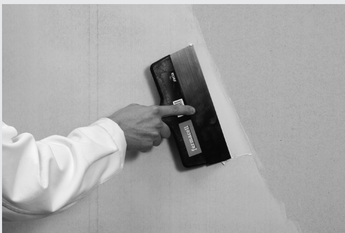
Bild 39: Flächenspachtelung von fermacell Gipsfaser-Platten
