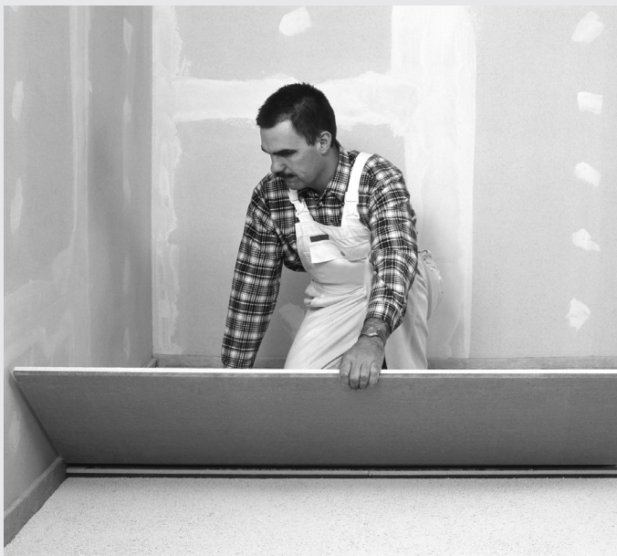
Bild 43: Das trittschall- und wärmedämmende fermacell Estrich-Element. Im Format 150 x 50 cm. In neun verschiedenen Dicken und Ausführungen lieferbar.
