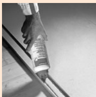
Verkleben der Falze mit FERMACELL Estrich-Kleber
