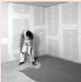
FERMACELL Wabenschüttung einbringen
