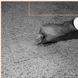
Mit der Glättkelle werden Unebenheiten egalisiert
