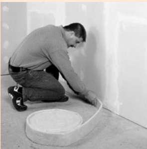
Aufbringen der Randdämmstreifen
