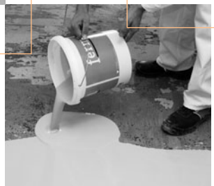
Boden-Nivelliermasse ausbringen und planeben nivellieren
