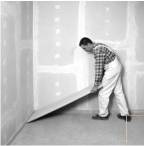
FERMACELL Estrich-Elemente verlegen
