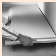
Verlegen der FERMACELL Estrich- Elemente
