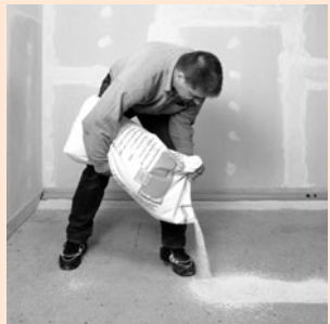
Anlegen der Dämme
