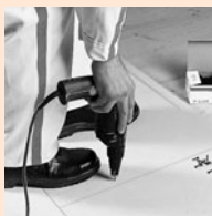
Befestigen durch Verschrauben ...
