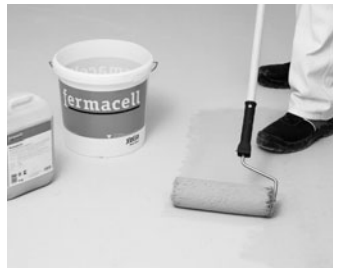
Vorbereitung: Boden grundieren und Randdämmstreifen verlegen
