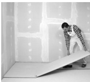
Verlegen der FERMACELL Estrich-Elemente auf FERMACELL Ausgleichsschüttung
