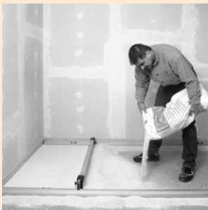
FERMACELL Ausgleichsschüttung einbringen
